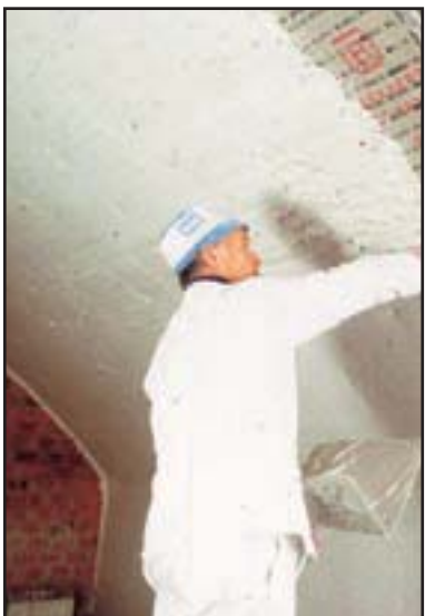
Budynek EEC – Bruksela. Stucanet® na sufitych łukowych
